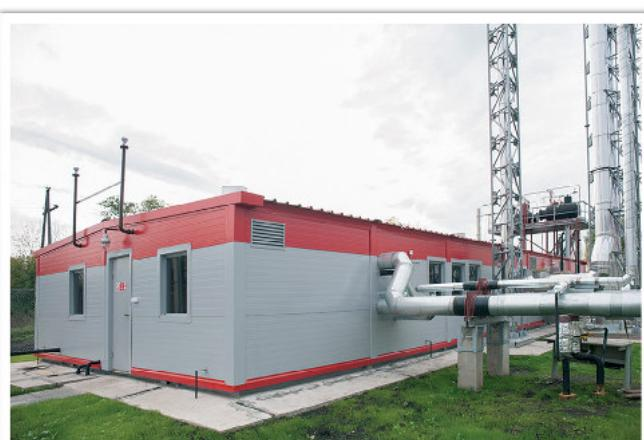
Котельная обеспечивает потребителей горячей водой по температурному графику 95/70°C (для систем отопления и вентиляции), 60°C (для системы горячего водоснабжения) и насыщенным паром на технологические нужды давлением Р = 6 кгс/см<sup>2</sup> и температурой t = 164°C (технологическое теплоснабжение).
